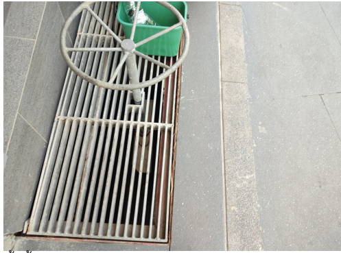
ภาพที่ 5-14 บ่อพักน้ำที่มีตะแกรงดักขยะ และ Stop Log ไม่มีขยะอุดตันสามารถระบายน้ำได้ดี
